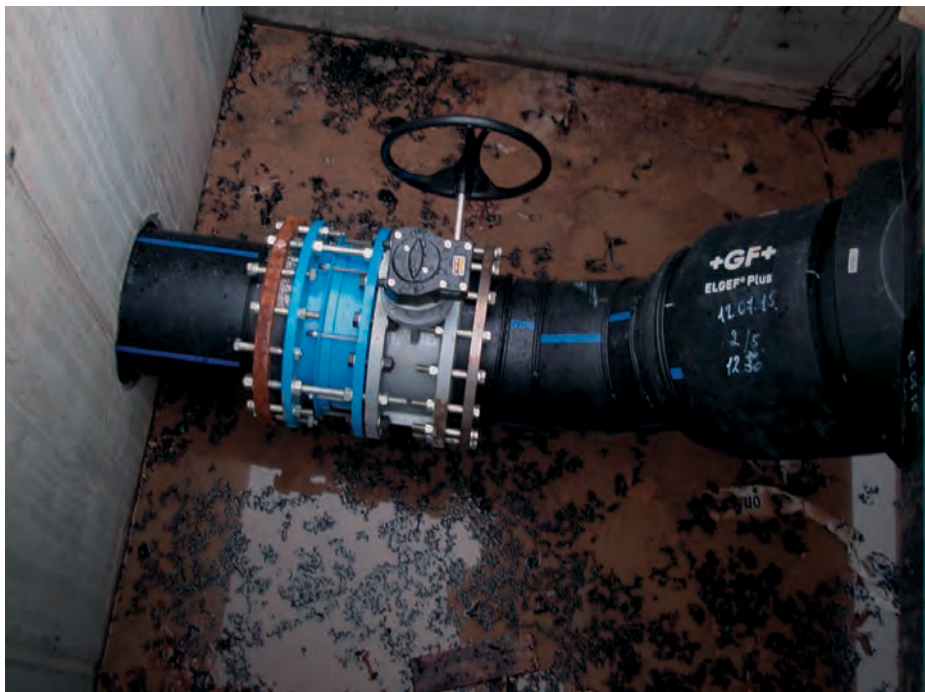
Рис. 2. Смонтированная врезка
