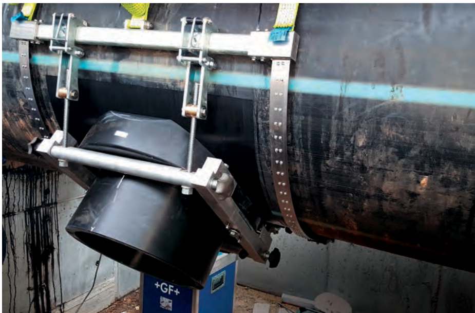
Рис. 1. Установка седелки на трубу
